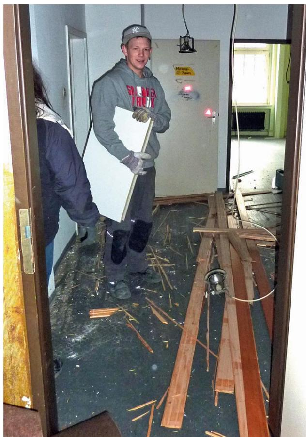
Inzwischen sind alle Deckenverkleidungen und Bodenbeläge aus dem Schnitkerhaus entfernt. (Foto: Uwe Finken)
